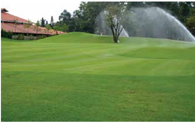
Thi công hệ thống tưới
