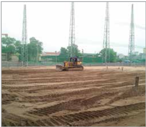
Thiết kế và thi công mặt nền
