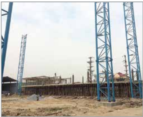
Thi công cột trụ căng lưới
