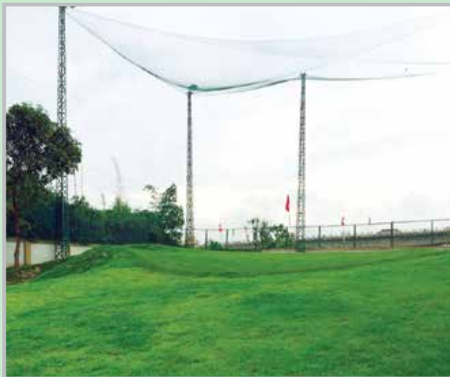
Thi công lưới bao che và lưới nóc
