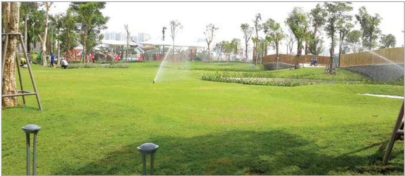
Thi công hệ thống tưới
